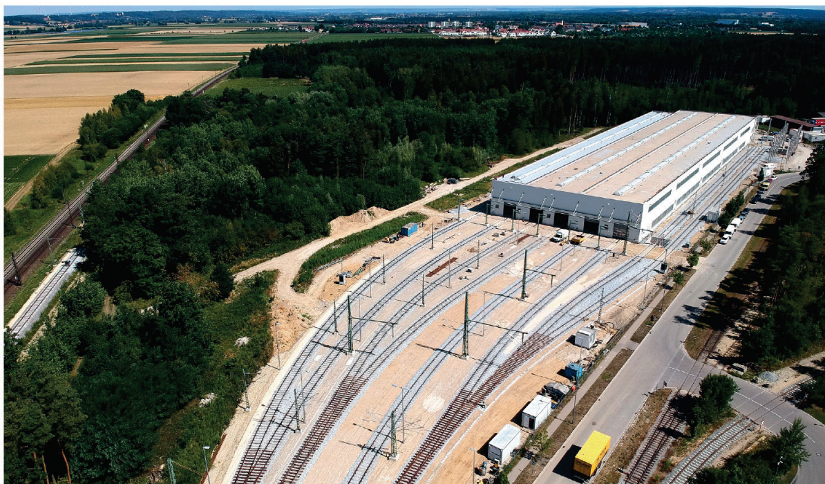
Wartungsstützpunkt für Schienenfahrzeuge, Langweid am Lech während der Bauphase: In Rekordzeit zur Hightech-Schlüsselstelle – modernste Instandhaltung in Süddeutschland Abb.: Quelle EUCO Rail
